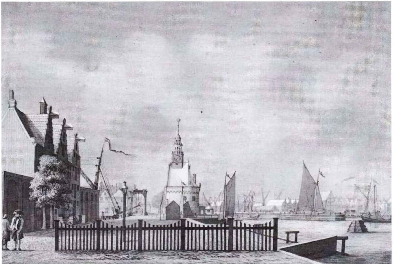
Pieter Aertsz Blaauw. Gezicht op de Hoofdtoren vanaf de Rouaanse kade (1786). Pentekening. Hoorn, Westfries Museum.
