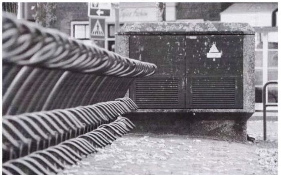
Veemarkt met verwaarloosd electriciteitsgebouwtje
