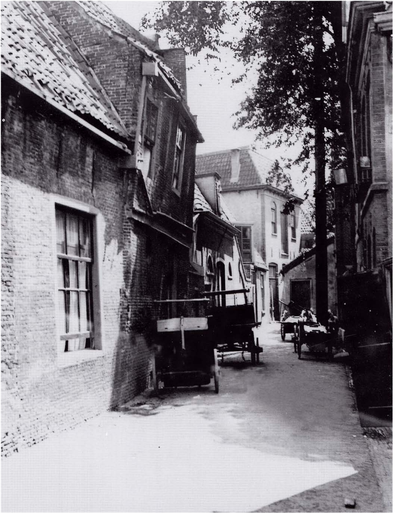
± 1930. Het Glop, zijstraatje van de Lange kerkstraat. Links achteraan het pakhuis van de familie Schrickx. Het pand vooraan links is in 1970 verwoest door brand en gesloopt
