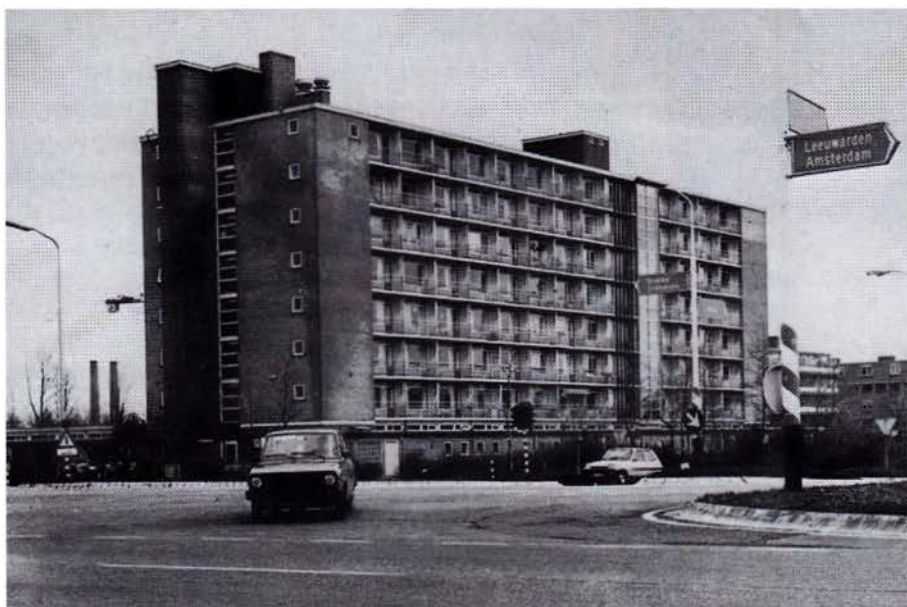
Eind jaren vijftig. De Liorne-flat gebouwd in 1956: de eerste hoogbouw in Hoorn
