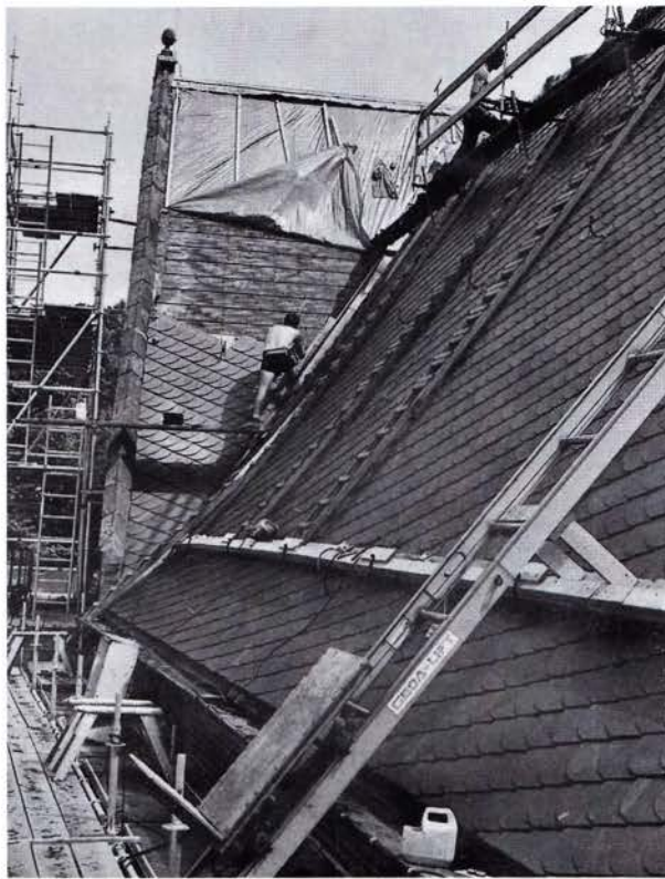
Restauratie dak Noorderkerk
