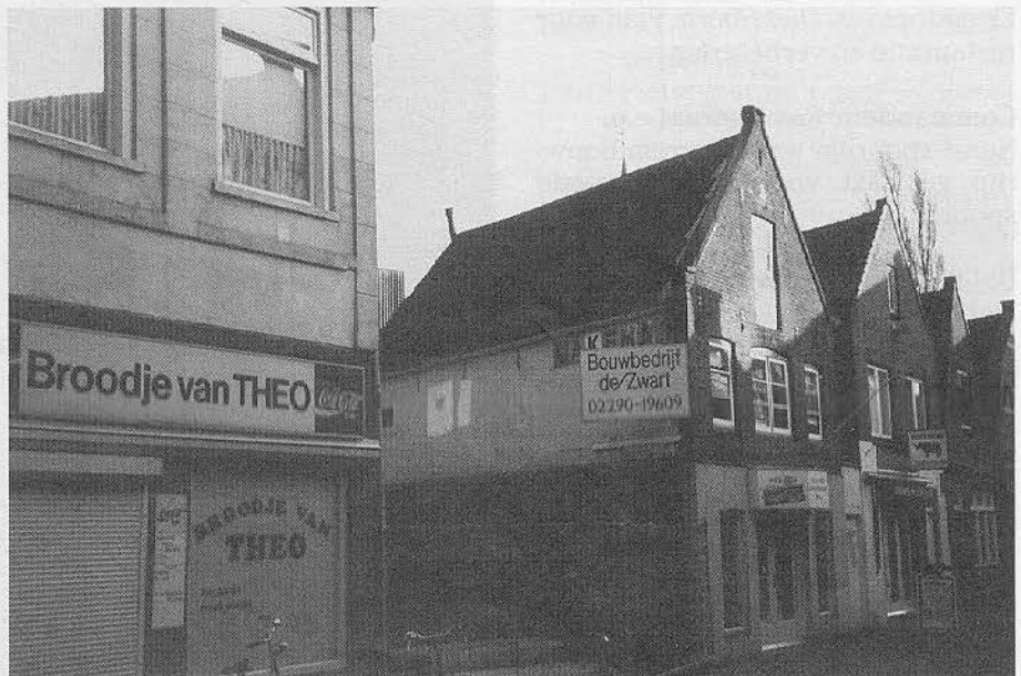
Nieuwe Noord: gat in gevelwand bij Nieuwsteeg.
