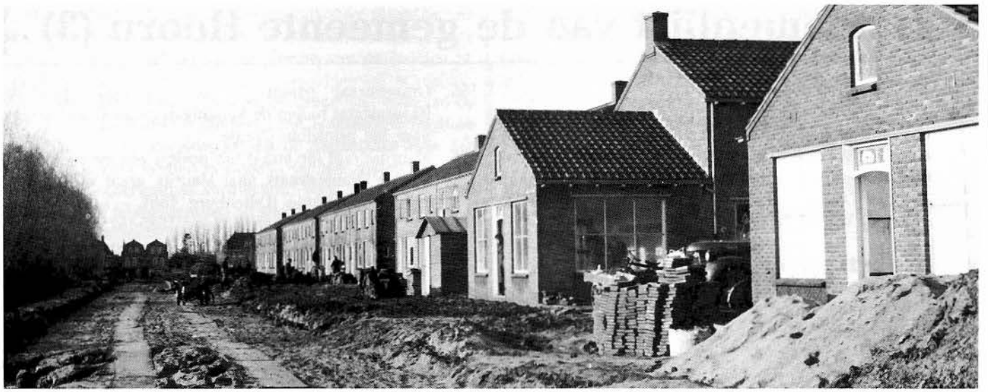
De Johannes Poststraat moet nog worden aangelegd. .
