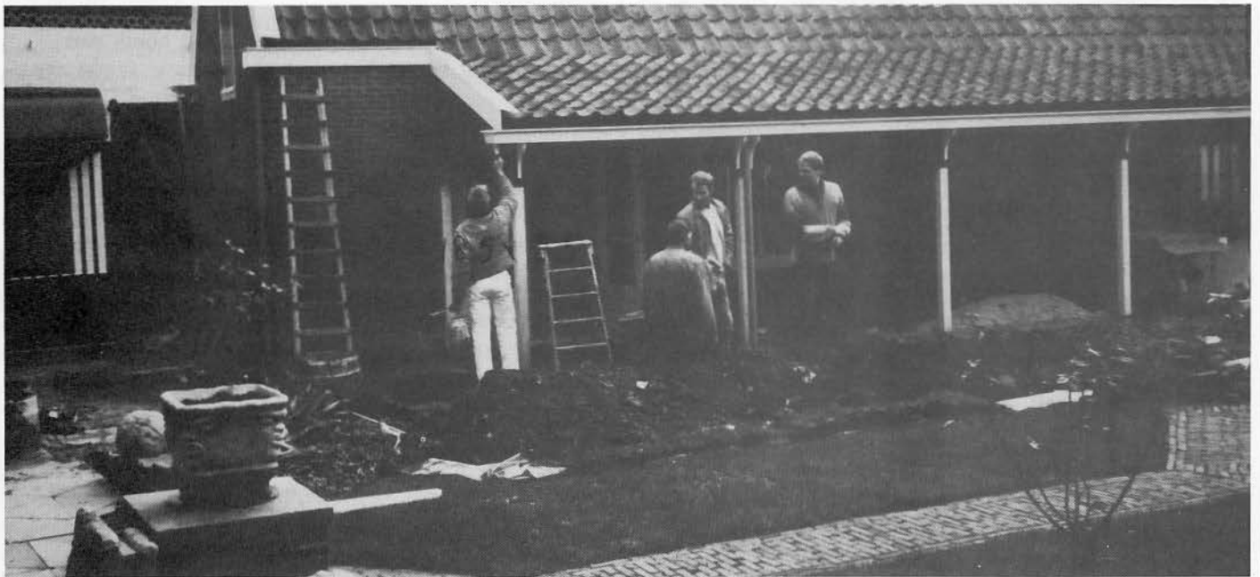
Binnenplaats Westfries Museum; werkzaamheden aan Proostensteegpand.
