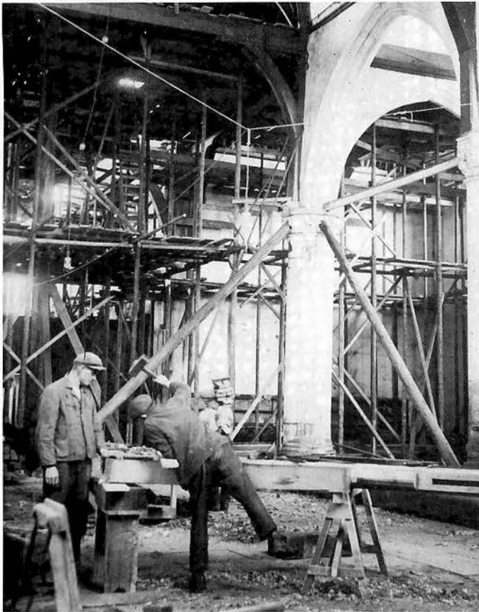
Een foto van de restauratie van ca. 50 jaar geleden. De aandacht ging vooral uit naar dak en gewelf, vandaar de vele (dikke) steigerpalen. Wel een verschil met de steigers van 1985!
