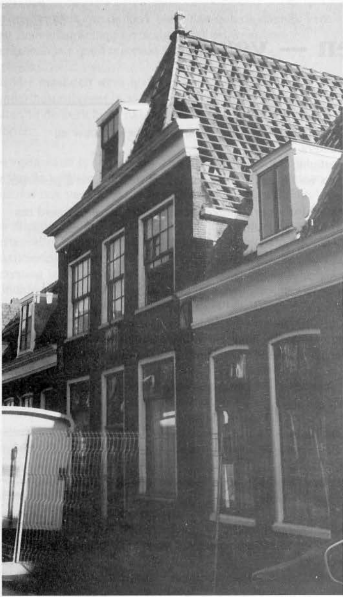
Grote Oost 114, restauratie.
