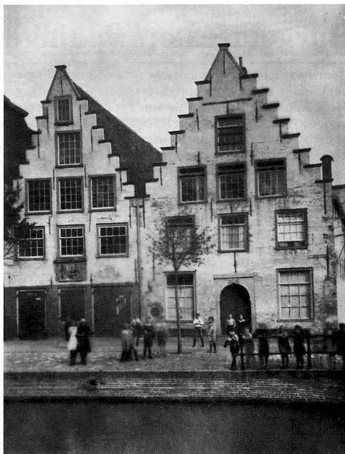
De VOC-pakhuizen aan Onder de Boompjes — nog ver voor de restauratie — en derhalve met een geheel ander aanzicht
