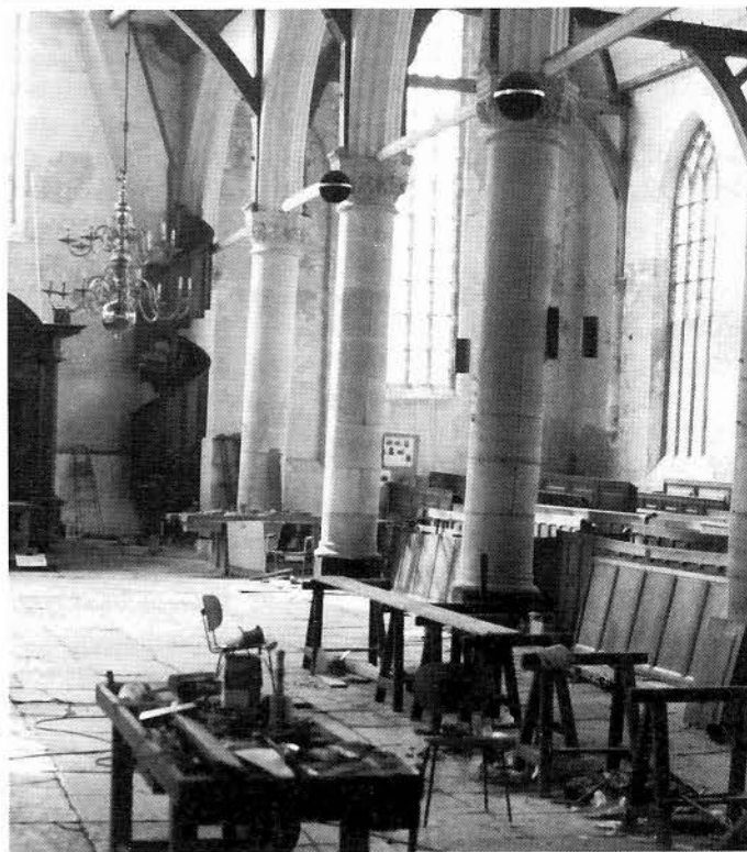
De Noorderkerk omgetoverd tot restauratiewerkplaats
