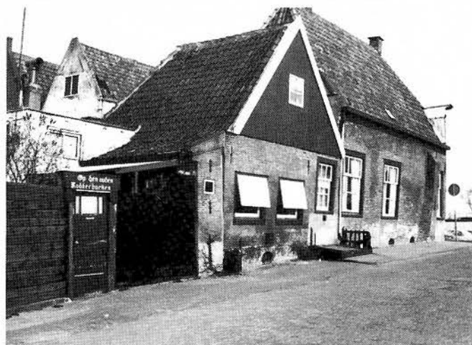
De zijde langs de Vollerswaal met aanbouw
