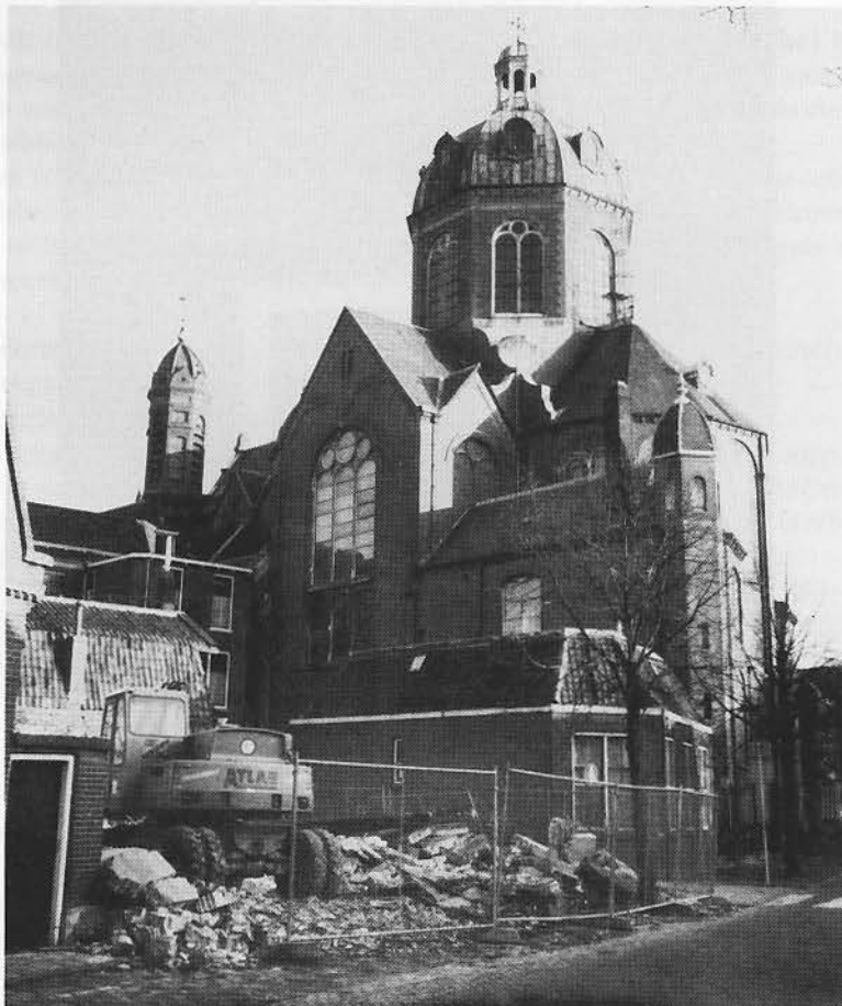
De sloop van Achterom 26-28
