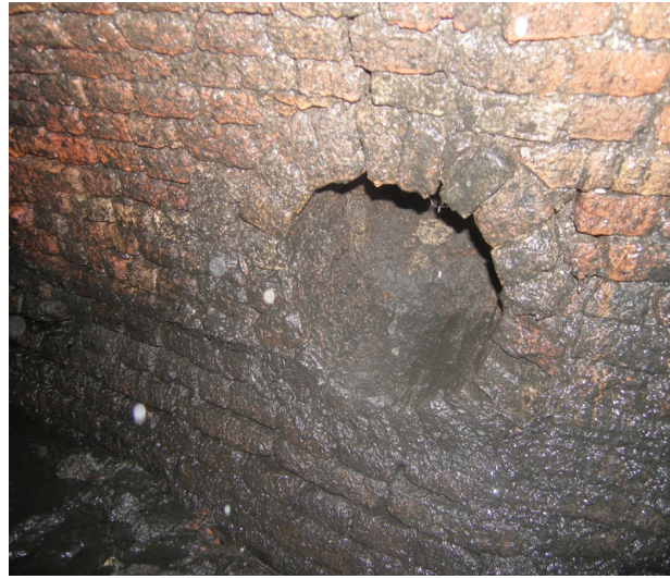
Figuren 5 & 6: Links de rioolgang onder de Boterhal en rechts een van de ronde gemetselde aansluitingen in de zuidwand
