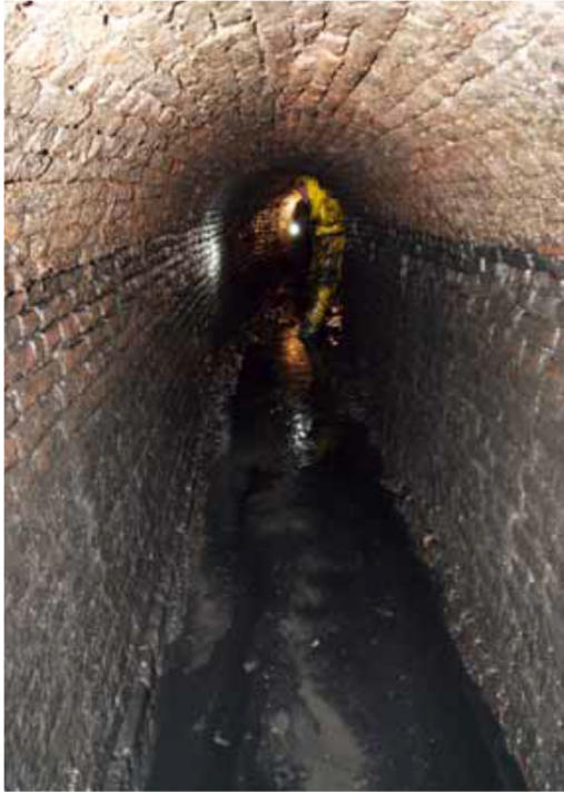
Figuren 5 & 6: Links de rioolgang onder de Boterhal en rechts een van de ronde gemetselde aansluitingen in de zuidwand
