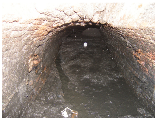
Figuur 4: Het riool (smalle deel) kijkend richting het oosten richting Boterhal). Op de bodem lag eerst nog een dik pakket slib.
