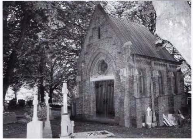
Hier de kapel op het kerkhof aan de Drieboomlaan, nog aan de vooravond van de restauratie. Veel van de ramen liggen er uit en de elementen hebben hierdoor vrij spel gekregen.
