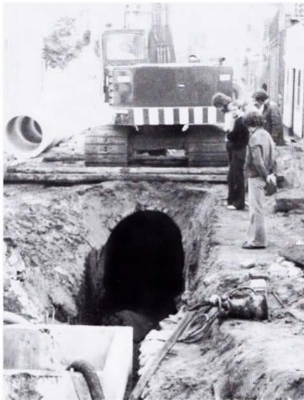
Het leggen van de nieuwe rioolbuis in het uit de middeleeuwen stammende riool van het Gerritsland; in wezen is dit een overluisd grachtje (midden zeventiger jaren)
